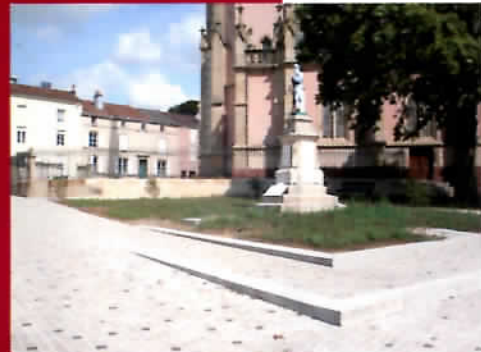
La place Marchal après travaux : mise en valeur du Monument aux Morts
