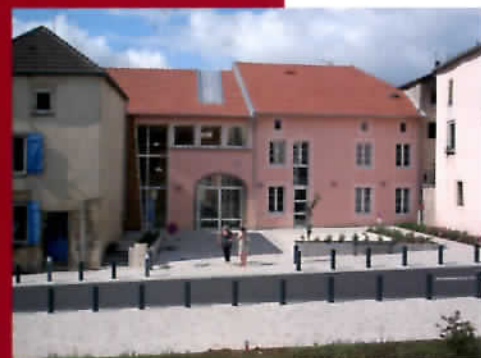
La halle après transformation : mise en œuvre d'un espace public piéton de part et d'autre de la rue
