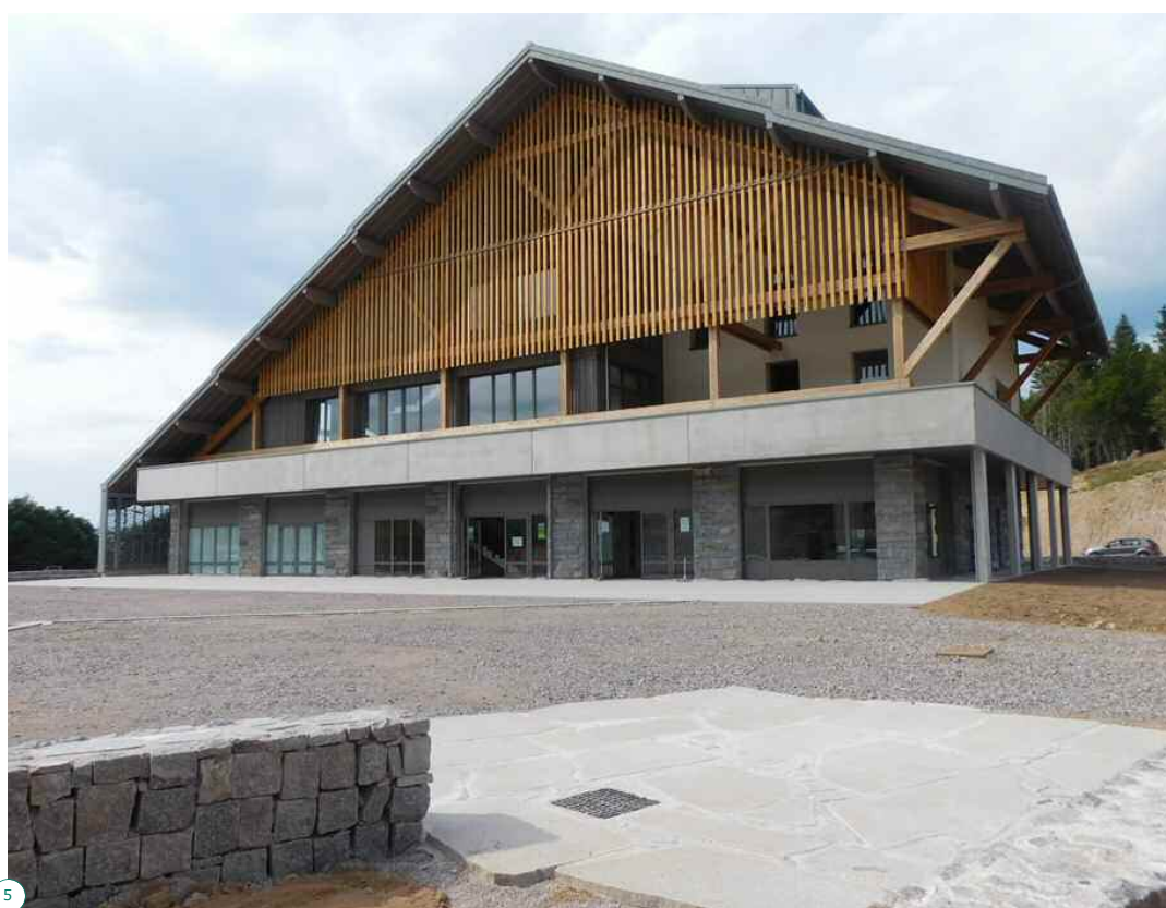
1. Plan d'aménagement 2. Vue sur la Halle 3. Abords du bâtiment Tétrás 4. Détail du parvis du bâtiment Tétrás 5. Entrée du bâtiment Tétrás. (Plan & Photographies : Atelier de paysage)
